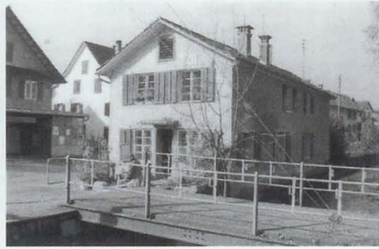
Ansicht von Südosten (Inventar AD&AD 1988)
