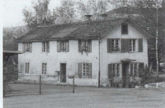
Ansicht von Südwesten (Inventar AD&AD 1988)
