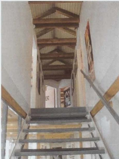
Treppe ins Obergeschoss
