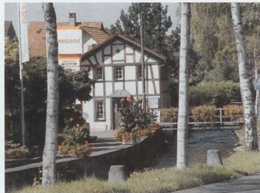
Ansicht von Süden mit dem Steg über den Jonenbach
