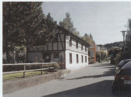
Blick zwischen den beiden Nachbargebäuden Schmiede Stierli Vers. Nr. 549 und dem Wohnhaus Vers. Nr. 553
