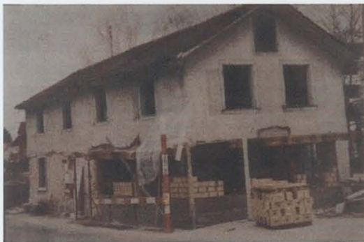
Aufnahme während des Umbaus 1991 (Jürg Büchi)
