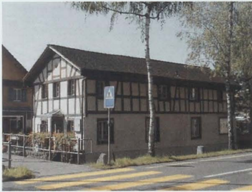
Ansicht von Südosten
